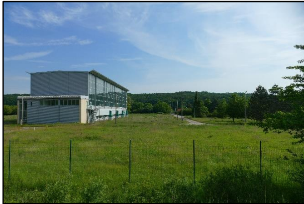
Abb. 2: Extensive Grünfläche und Verdichterhalle (Blickrichtung Nord-Osten)
